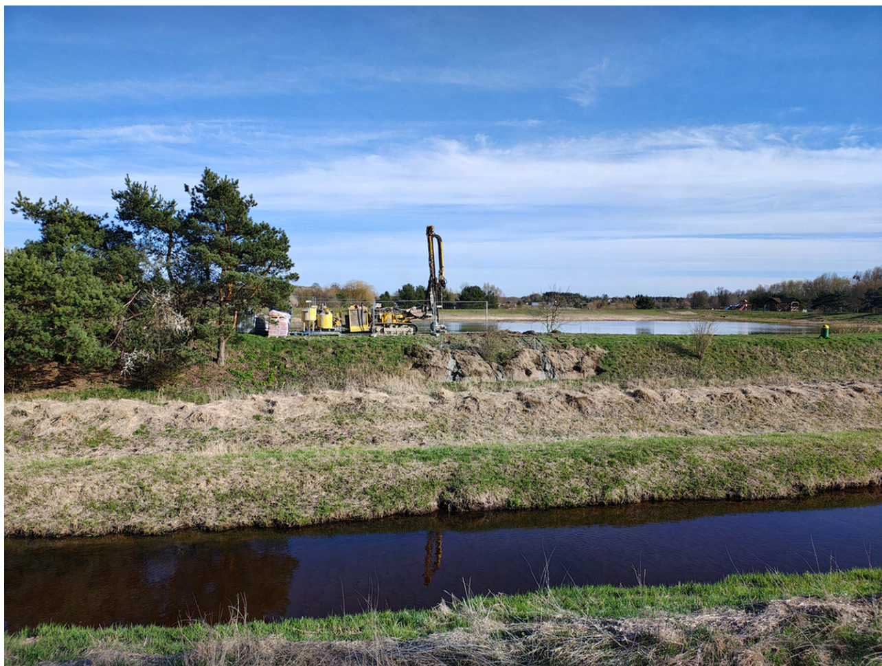
Rzeka Włodawka. W tym miejscu powstanie kładka pieszo-rowerowa
